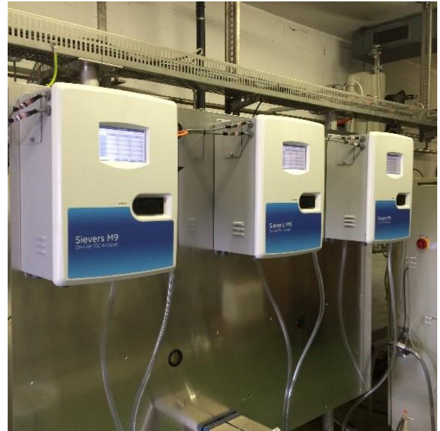
图 1：三台 Sievers*在线型 M9 TOC 分析仪监测流出的混合冷却水
